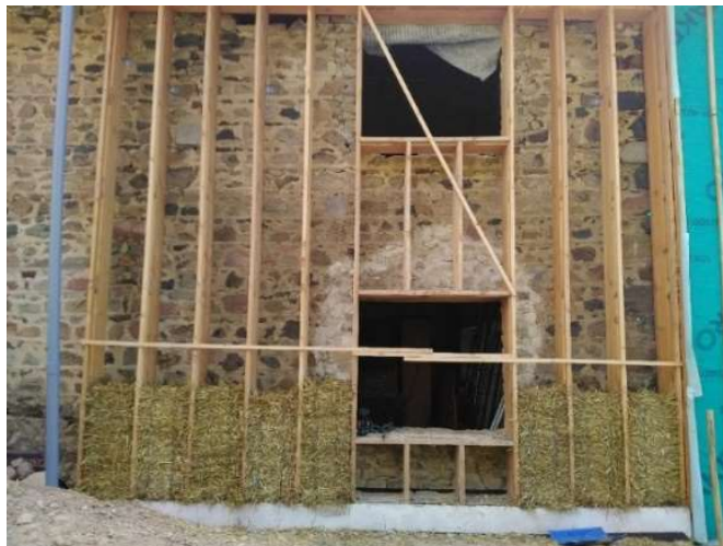
Figure 11 : Réalisation d'une ITE paille sur bâti ancien, St Apollinaire
