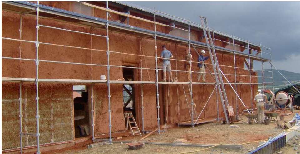
Figure 15 : Chantier d'enduit, Les Jardin de Cocagne, 2007
