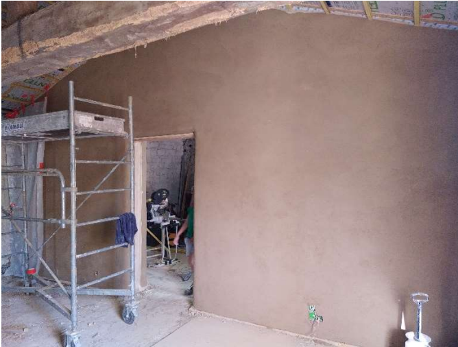
Figure 13 : enduit de finition sur bottes de paille, CREB 2021, Oikos
