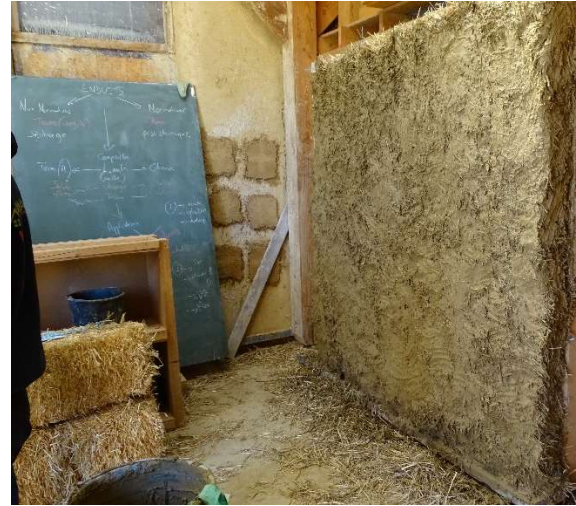
Figure 14 : enduit de corps, formation Propaille, Oikos
