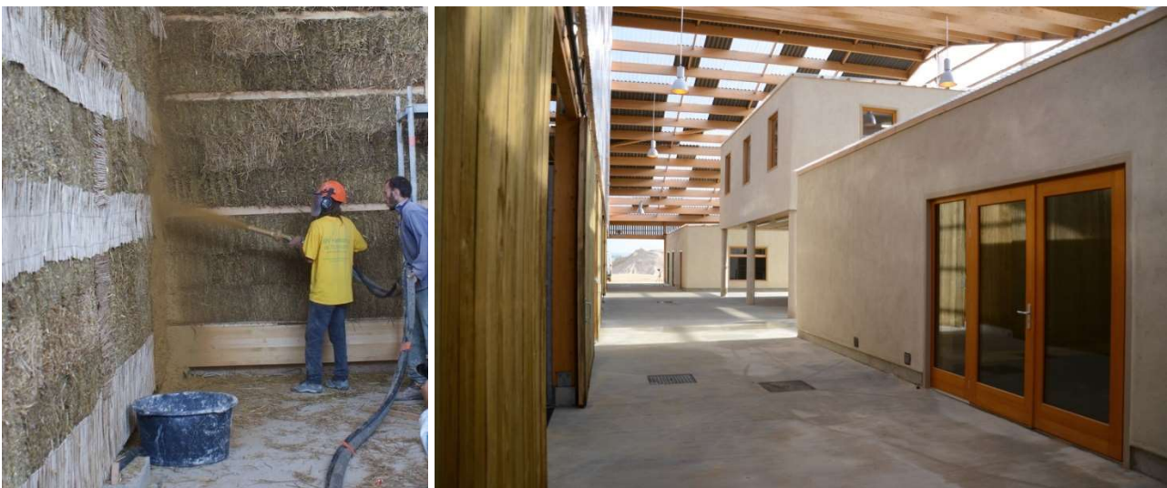
Figure 16 : MV Habitation, Projection d'enduit
