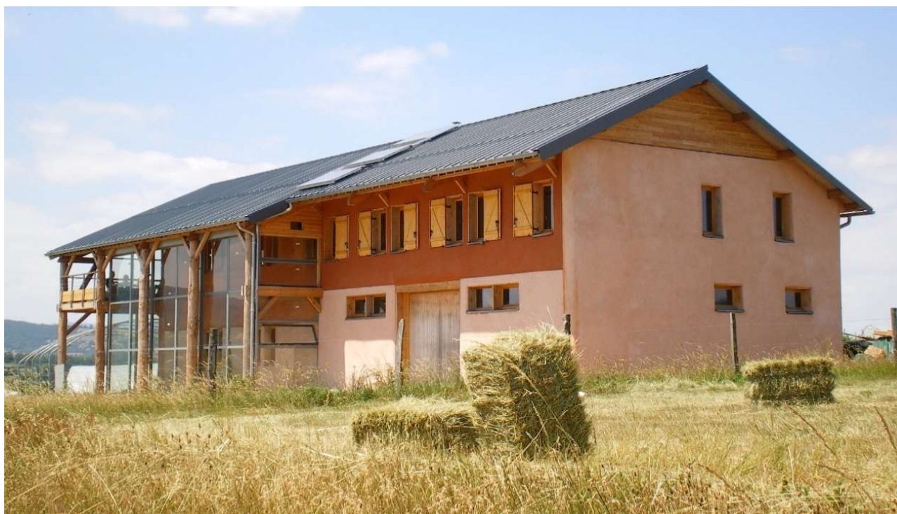
Figure 1 : Ecocentre du Lyonnais, Architecte Stéphane Peignier
