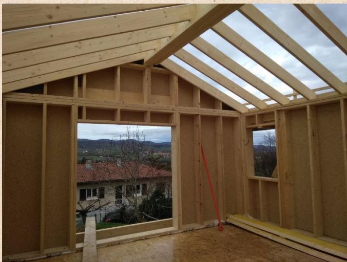
↑ La dalle bois du RDC fixée sur les soubassements
