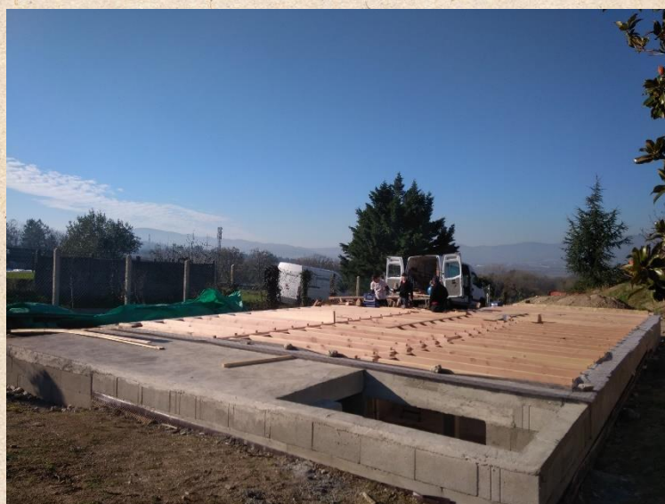
↑ La dalle bois du RDC fixée sur les soubassements
