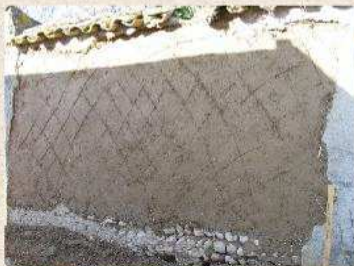
Résultat avant l'application de l'enduit de finition
